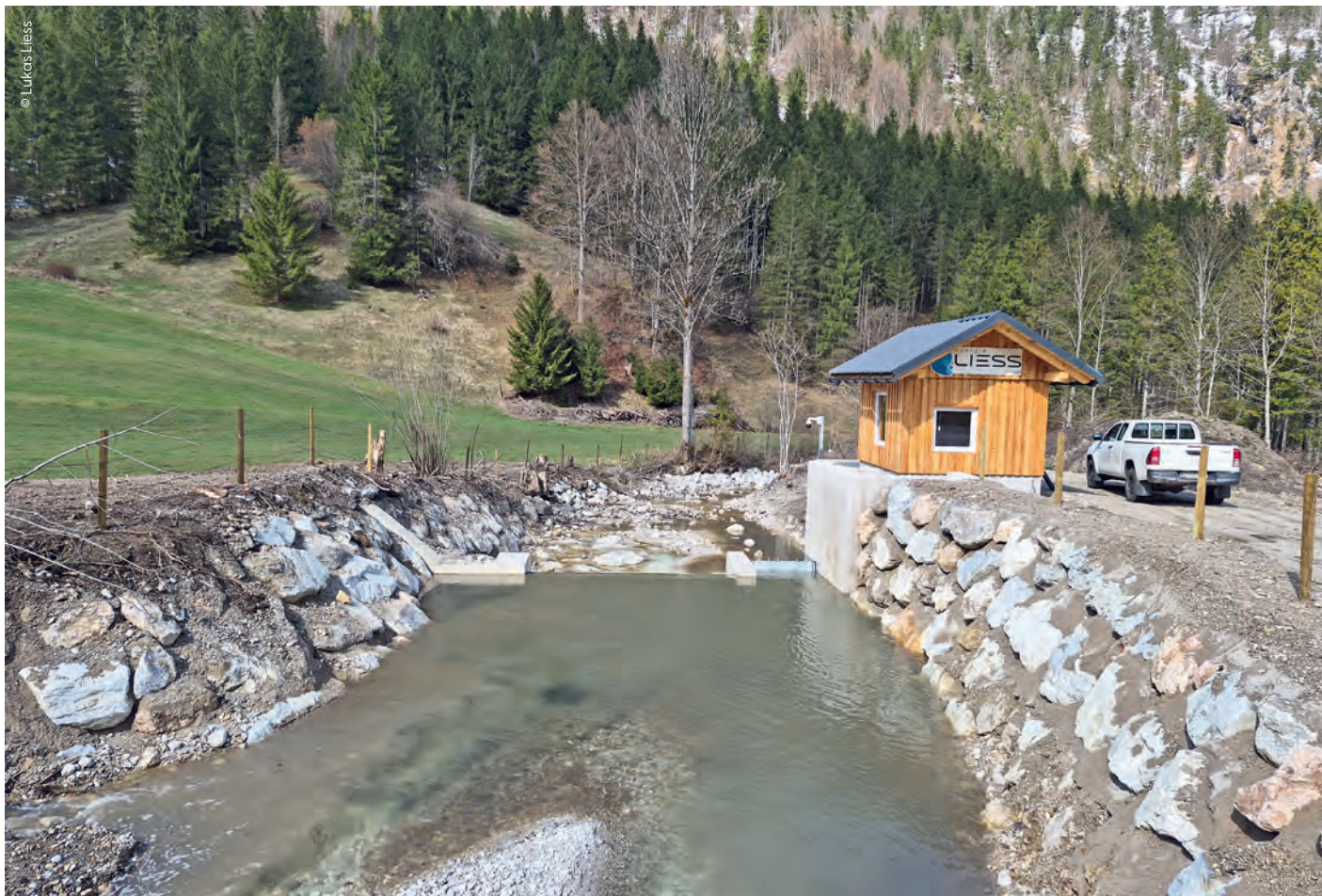
Das neue Kleinwasserkraftwerk am Mühlbach in der Obersteiermark kann im Regeljahr rund 600.000 kWh Ökostrom erzeugen.
