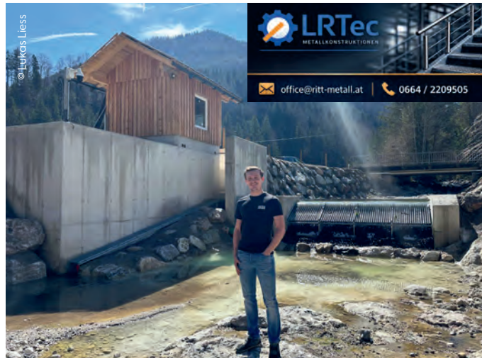
Kraftwerksbetreiber Lukas Liess hat mit seinem Metallbauunternehmen LRTec diverse Stahlwasserbauteile in Eigenregie gefertigt.
