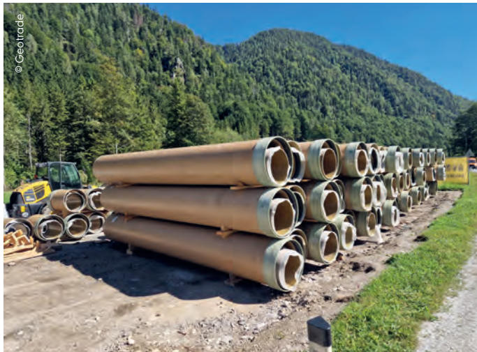
Um Transportkosten zu sparen, wurde die Druckrohrleitung mit SUPERLIT GFK-Rohren in den Dimensionen DN800 und DN600 ausgeführt.
