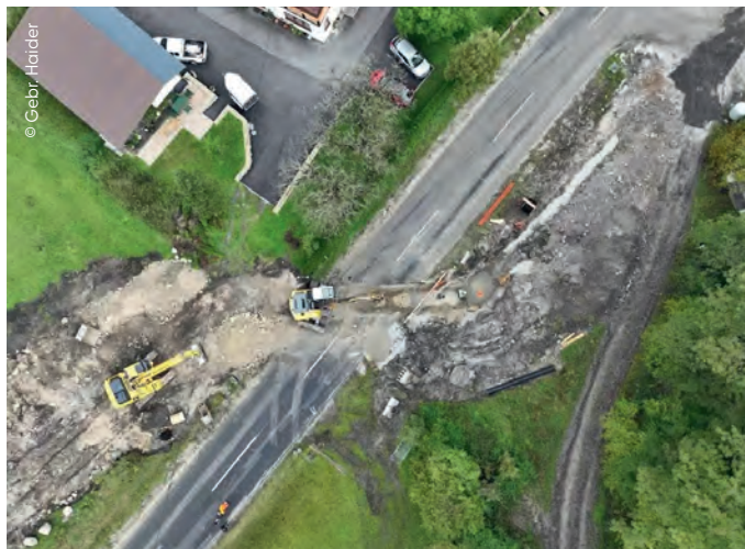
Bauarbeiten für die Druckleitungs-Unterquerung der Landstraße
