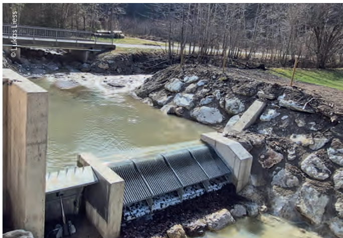
An der Wasserfassung erfolgt der Triebwassereinzug durch ein Coanda-System von der Südtiroler Wild Metal GmbH.
