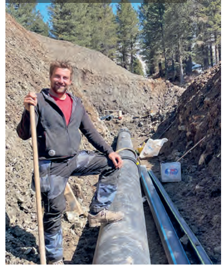
Betreiber Luca Runggaldier hat beim Neubau seines Kraftwerks tatkräftig Hand angelegt.
