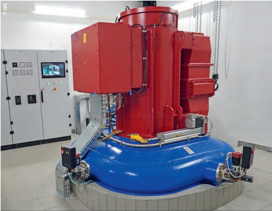
Die 4-düsige Pelton-turbine aus dem Hause Sora treibt einen wassergekühlten Synchrongenerator von Marelli Motori mit 600 kVA an. Was besonders auffällt, ist die kompakte Bauform der Turbine. Sie kommt auf 454 kW Leistung.
