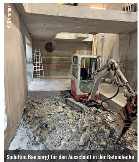
Spiluttini Bau sorgt für den Ausschnitt in der Betondecke.
