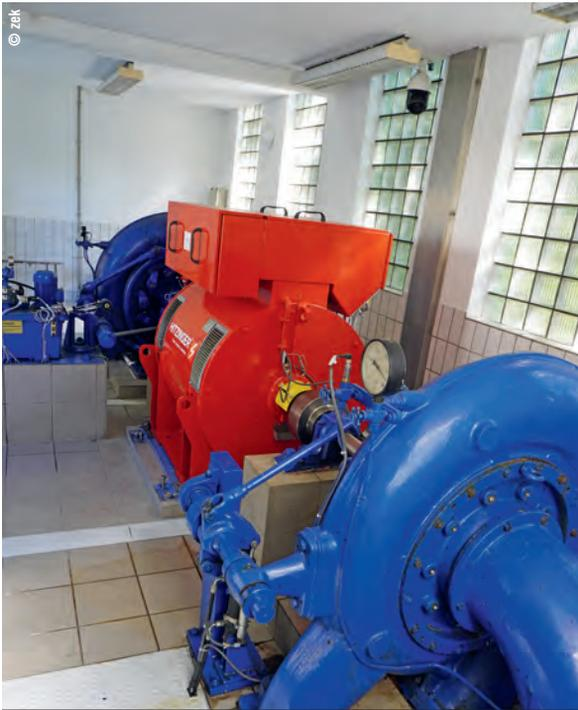
Die beiden Francis-Turbinen im Ausgleichskraftwerk, die zuvor auf zwei verschiedene Generatoren aufgeteilt waren, wurden zur Leistungsoptimierung wieder auf eine Welle und einen Generator zusammengeführt. Der Generator wurde dabei komplett erneuert.
