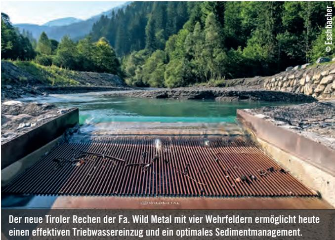
Der neue Tiroler Rechen der Fa. Wild Metal mit vier Wehrfeldern ermöglicht heute einen effektiven Triebwassereinzug und ein optimales Sedimentmanagement.
