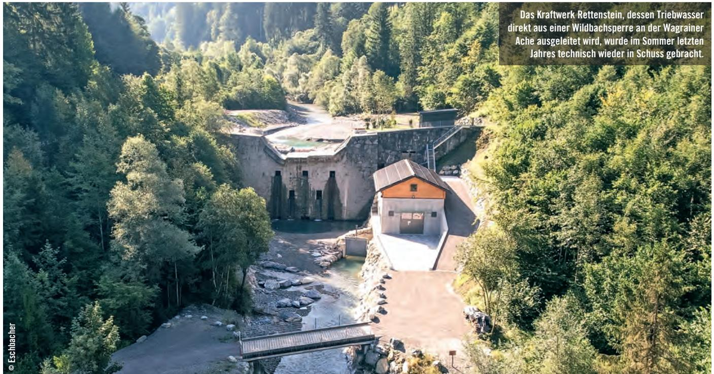
Das Kraftwerk Rettenstein, dessen Triebwasser direkt aus einer Wildbachsperre an der Wagrainner Ache ausgeleitet wird, wurde im Sommer letzten Jahres technisch wieder in Schuss gebracht.
