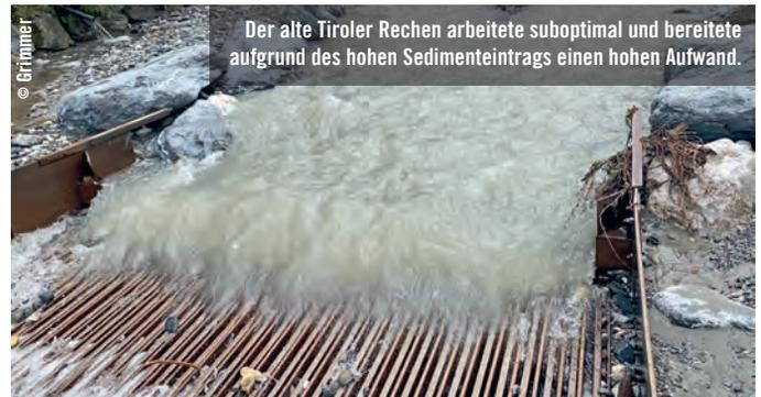
Der alte Tiroler Rechen arbeitete suboptimal und bereitete aufgrund des hohen Sedimenteintrags einen hohen Aufwand.
