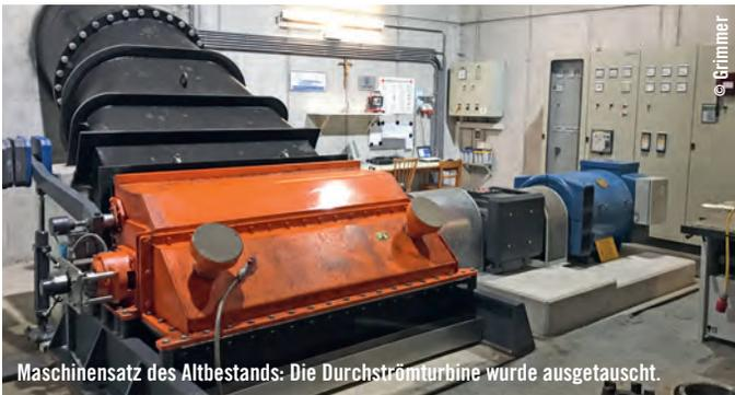
Maschinensatz des Altbestands: Die Durchströmerturbine wurde ausgetauscht.
