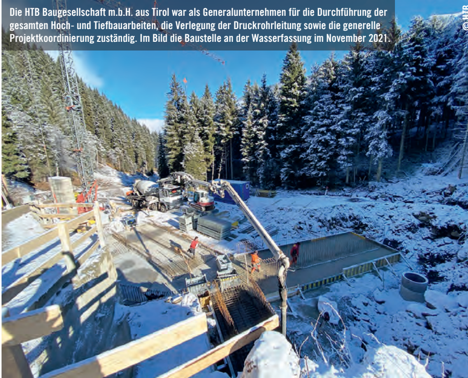
Schrämarbeiten mit dem Bagger bei der Verlegung der 2.253 m langen Druckrohrleitung DN800 aus duktilen Gussrohren von TRM.
