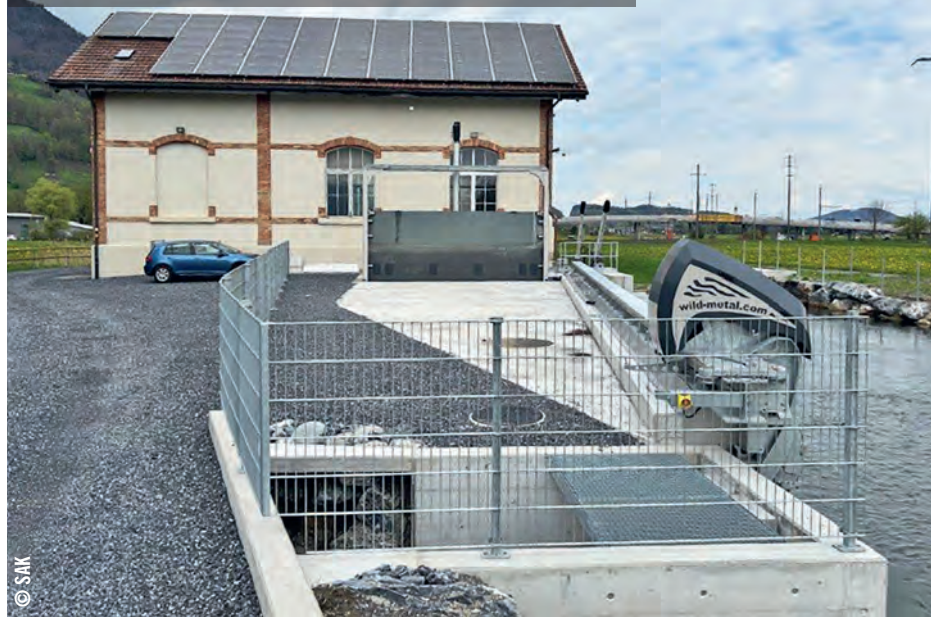
Für den baulich und technisch völlig neu gestalteten Einlaufbereich lieferte die Südtiroler Wild Metal GmbH einen horizontalen Einlaufrechen mit der dazugehörigen Rechenreinigungsmaschine in elektromechanischer Ausführung
