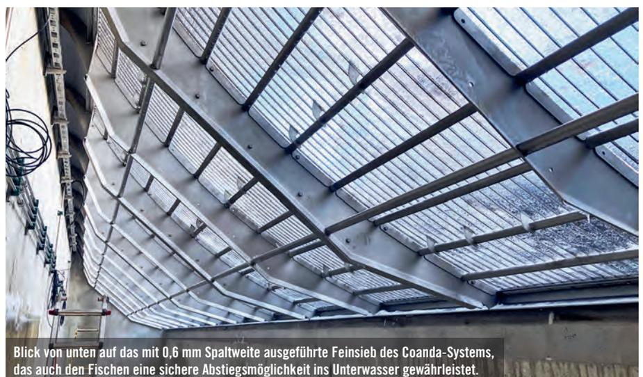
Blick von unten auf das mit 0,6 mm Spaltweite ausgeführte Feinsieb des Coanda-Systems, das auch den Fischen eine sichere Abstiegsmöglichkeit ins Unterwasser gewährleistet.
