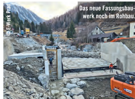
Über eine Gesamtlänge von 3,3 km erstreckt sich die Rohrtrasse, in der nicht nur die stählerne Druckrohrleitung, sondern auch eine Leitung für die Beregnung und eine Trinkwasserleitung unterirdisch verlegt worden sind.
