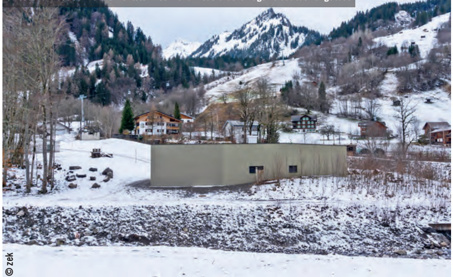
Mit dem Neubau des Wasserkraftwerks St. Theodul II hat die nachhaltige Stromerzeugung in der Gemeinde Brand erheblichen Zuwachs erhalten. Das neue Maschinengebäude wurde an das Krafthaus der 2014 errichteten Hoch- und Niederdruckanlage Paldüdbach angebaut.
