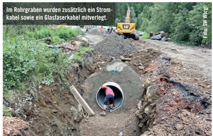
Das Aushubmaterial wurde von den Baufirmen auf der Baustelle zu Bettungsmaterial verarbeitet.
