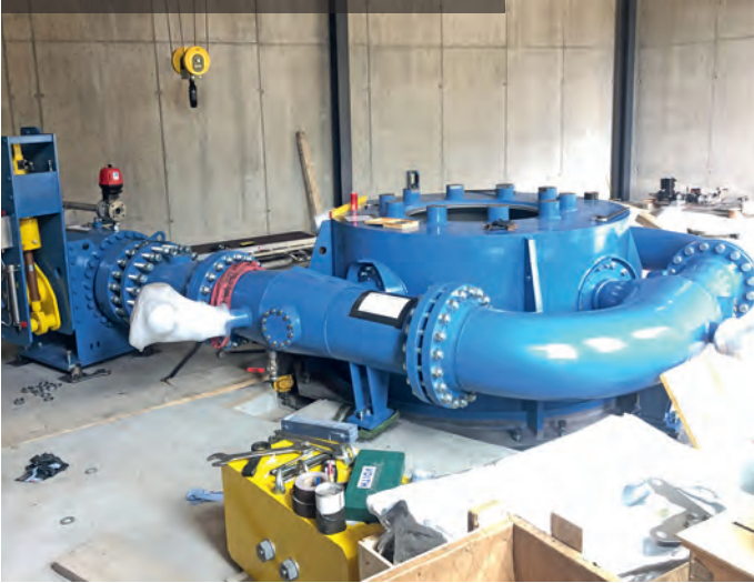
Das Turbinengehäuse mit den Zulaufrohren ist bereits installiert. Die 4-düsige Peltonturbine von Voith Hydro ist auf eine Leistung von 2,2 MW ausgelegt.
