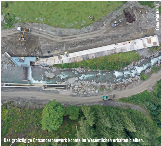
Sollte der direkte Wassereinzug aus dem Oberlieger-Kraftwerk nicht möglich sein, kann nun das Wasser auch über das neue Coanda-System aus dem Hause Wild Metal entnommen werden.
