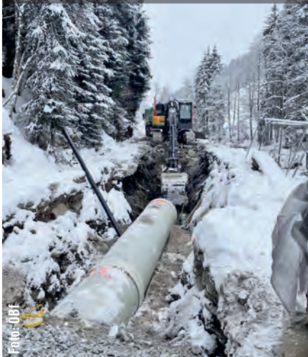
Der ca. 2,7 km lange Kraftabstieg DN1200 besteht zur Gänze aus GFK-Rohren vom Hersteller Amiblu.
