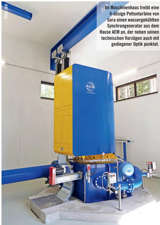
Im Maschinenhaus treibt eine 4-düsige Pelton turbine von Sora einen wassergekühlten Synchrongenerator aus dem Hause AEM an, der neben seinen technischen Vorzügen auch mit gediegener Optik punktet.
