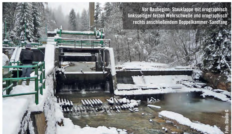
Vor Baubeginn: Stauklappe mit orographisch linksseitiger festen Wehrschwelle und orographisch rechts anschließendem Doppelkammer-Sandfang
