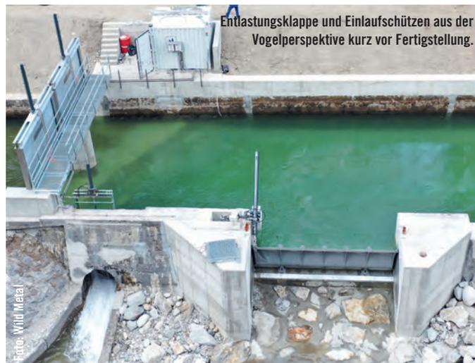
Entlastungsklappe und Einlaufschützen aus der Vogelperspektive kurz vor Fertigstellung.
