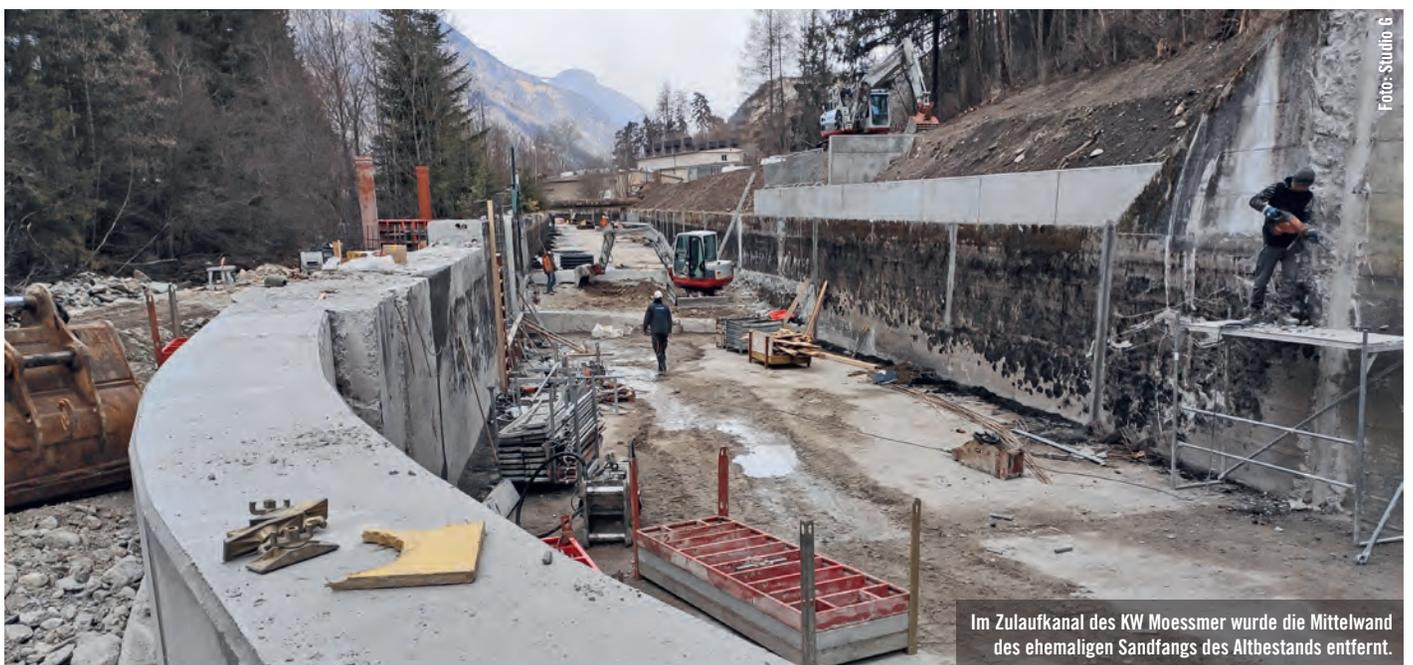
Im Zulaufkanal des KW Moessmer wurde die Mittelwand des ehemaligen Sandfanges des Altbestands entfernt.
