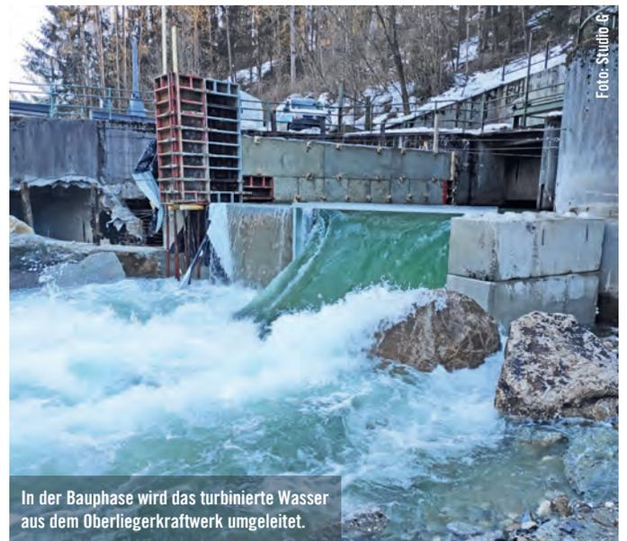
In der Bauphase wird das turbinierete Wasser aus dem Oberliegerkraftwerk umgeleitet.
