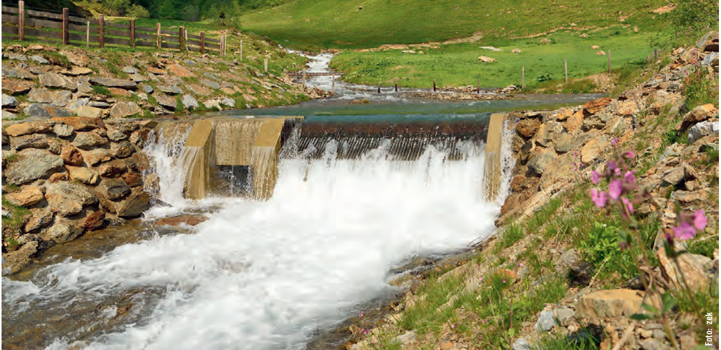
Knapp unterhalb des Zusammenflusses von Thalerbach und Gampenbach wurde die Wasserfassung bei der Pedretsch Kaser auf circa 1.700 m Seehöhe angelegt. Für einen sicheren und zuverlässigen Einzug des Triebwassers sowie eine korrekte Dotation des Restwassers wurde ein Rechen mit Coanda-System vom Typ Grizzly der Firma Wild Metal installiert.
