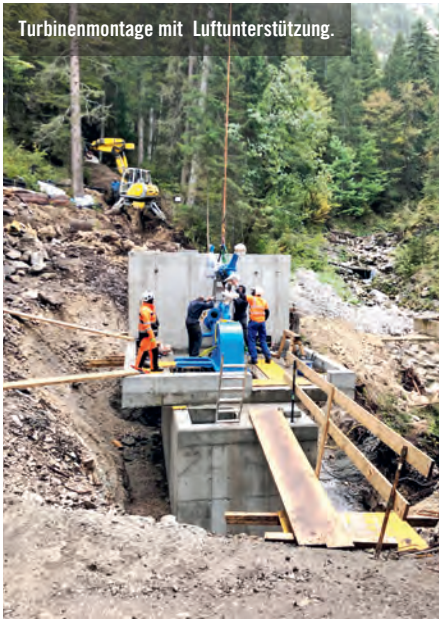
Für den Materialtransport in das nur zu Fuß erreichbare Projektgebiet waren in Summe rund 480 Helikopterflüge notwendig. Die Betonarbeiten am Kräftehaus und der Wehranlage wurden von der im Wasserkraftbereich seit Jahrzehnten bewährten Dobler GmbH & Co. KG Bauunternehmung umgesetzt. Im Bild die Baustelle an der Wasserfassung im Oktober 2020.
