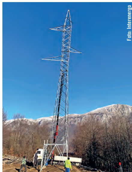
Bild links: Turbinenmontage: Spiralgehäuse und Verteilrohrleitung wurden im Mai letzten Jahres geliefert und eingehoben. Es handelt sich um eine 6-düsige vertikalachsige Pelton turbine mit 6 MW Leistung. Bild rechts: Rund ein Jahr nahmen die Arbeiten für den Bau der 8 Kilometer langen 35 kV-Hochspannungsleitung in Anspruch.
