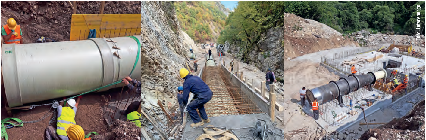
Auf einer Gesamtlänge von rund 3 Kilometern wurden GFK-Rohre vom Typ Superlit DN1400 (Bild links) verlegt. Die Rohrtrasse folgte größtenteils einer bestehenden Landstraße.
