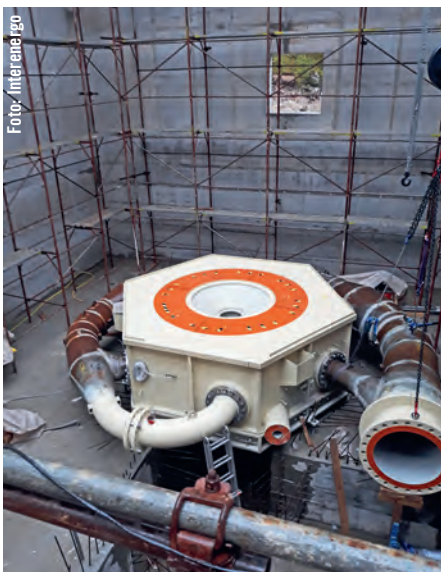
Bild links: Turbinenmontage: Spiralgehäuse und Verteilrohrleitung wurden im Mai letzten Jahres geliefert und eingehoben. Es handelt sich um eine 6-düsige vertikalachsige Pelton turbine mit 6 MW Leistung. Bild rechts: Rund ein Jahr nahmen die Arbeiten für den Bau der 8 Kilometer langen 35 kV-Hochspannungsleitung in Anspruch.
