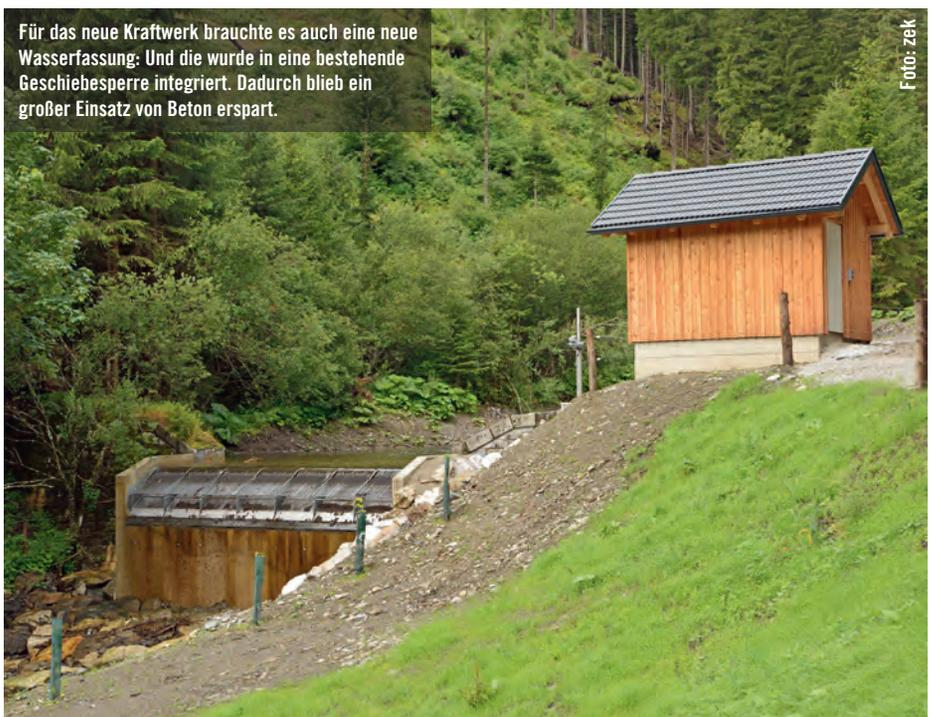
Für das neue Kraftwerk brauchte es auch eine neue Wasserfassung: Und die wurde in eine bestehende Geschiebesperre integriert. Dadurch blieb ein großer Einsatz von Beton erspart.
