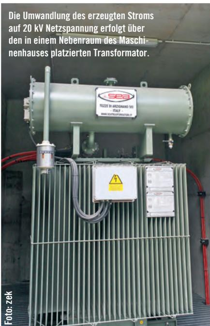
Die Umwandlung des erzeugten Stroms auf 20 kV Netzspannung erfolgt über den in einem Nebenraum des Maschinenhauses platzierten Transformator.
