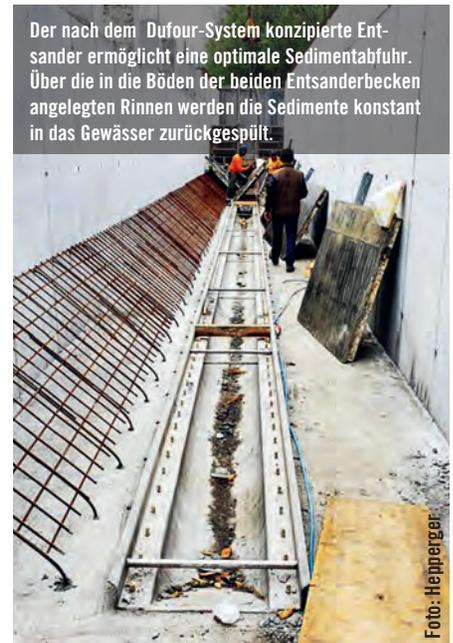
Der nach dem Dufour-System konzipierte Ent-sander ermöglicht eine optimale Sedimentabfuhr. Über die in die Böden der beiden Ent-sanderbecken angelegten Rinnen werden die Sedimente konstant in das Gewässer zurückgespült.
