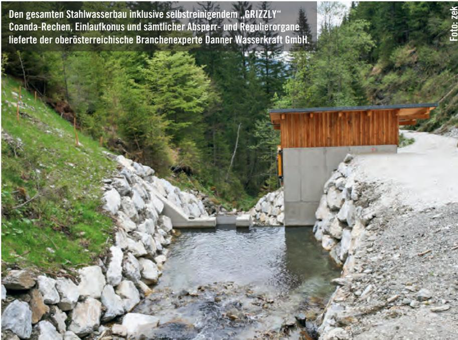
Den gesamten Stahlwasserbau inklusive selbstreinigendem „GRIZZLY“ Coanda-Rechen, Einlaufkonus und sämtlicher Absperr- und Regulierorgane lieferte der oberösterreichische Branchenexperte Danner Wasserkraft GmbH.
