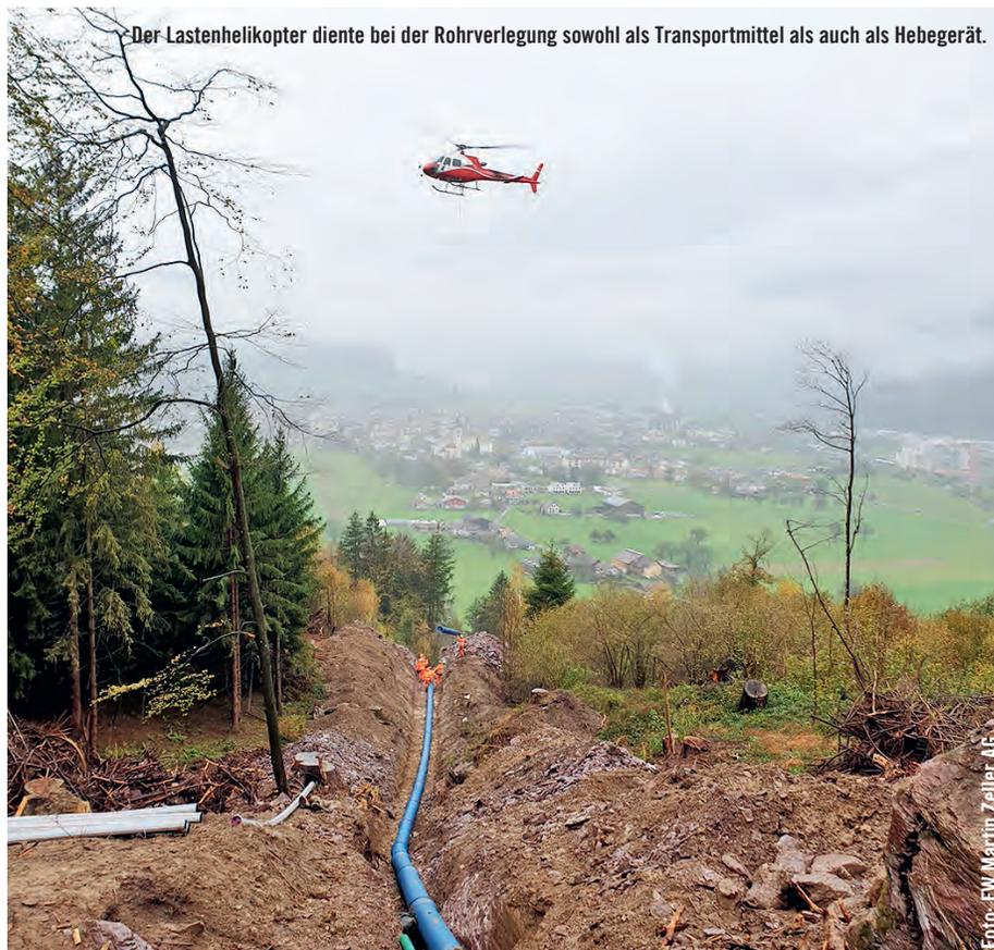
Der Lastenhelikopter diente bei der Rohrverlegung sowohl als Transportmittel als auch als Hebegerät.
