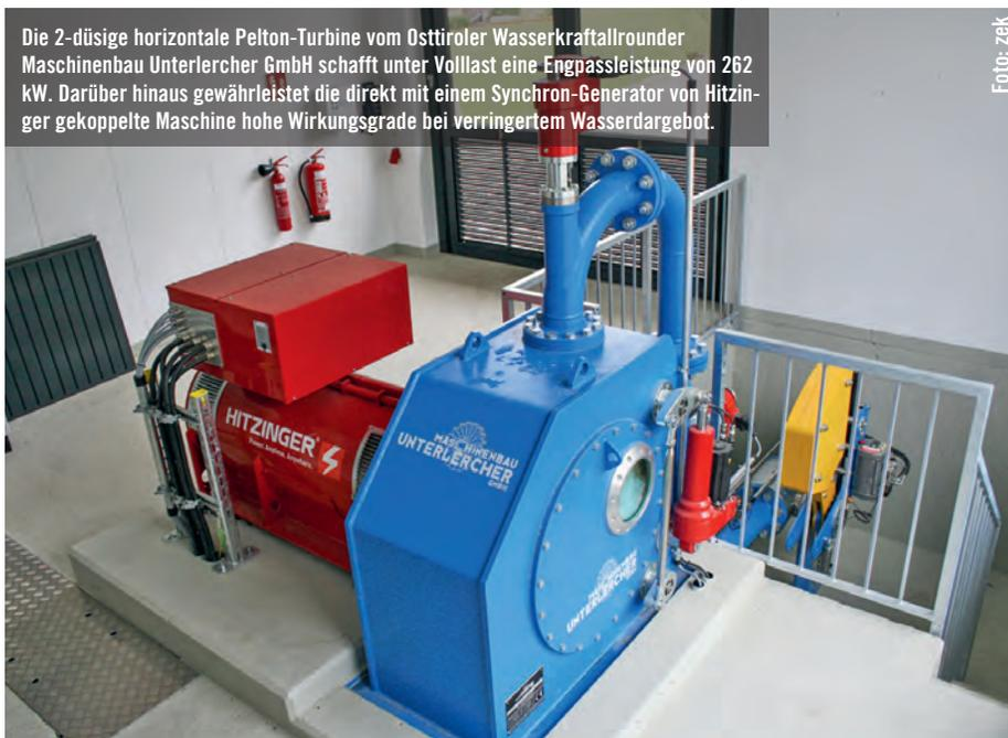
Die 2-düsige horizontale Pelton-Turbine vom Osttiroler Wasserkraftallrounder Maschinenbau Unterlercher GmbH schafft unter Volllast eine Engpassleistung von 262 kW. Darüber hinaus gewährleistet die direkt mit einem Synchron-Generator von Hitzinger gekoppelte Maschine hohe Wirkungsgrade bei verringertem Wasserdargebot.
