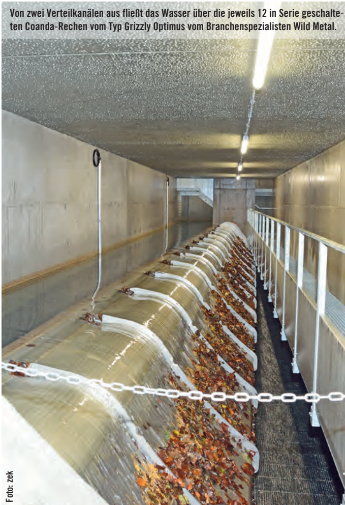
Dank des speziellen Entsandungskonzeptes der unterirdischen Coanda-Anlage kann eine negative Beeinflussung des Betriebs der Unterlieger-Anlage auf ein Minimum beschränkt werden. Das Restwasser wird hier auch zu Spülzwecken verwendet.
