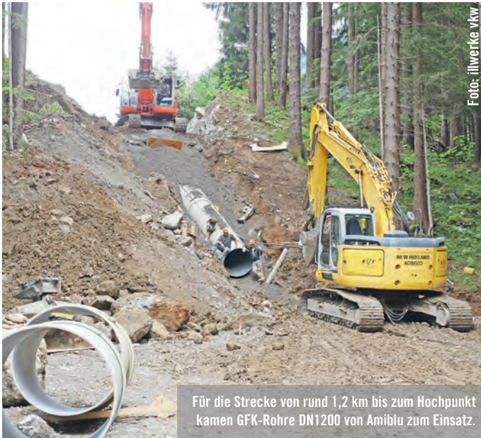
Das mit der Rohrverlegung beauftragte Bauunternehmen Wilhelm+Mayer setzte zwei 24-Tonnen Bagger ein. Im Bild: Der Einbau der duktilen Gussrohre DN1000, die über eine Länge von 1,9 km unterirdisch verlegt wurden – eine aufwändige Arbeit.
