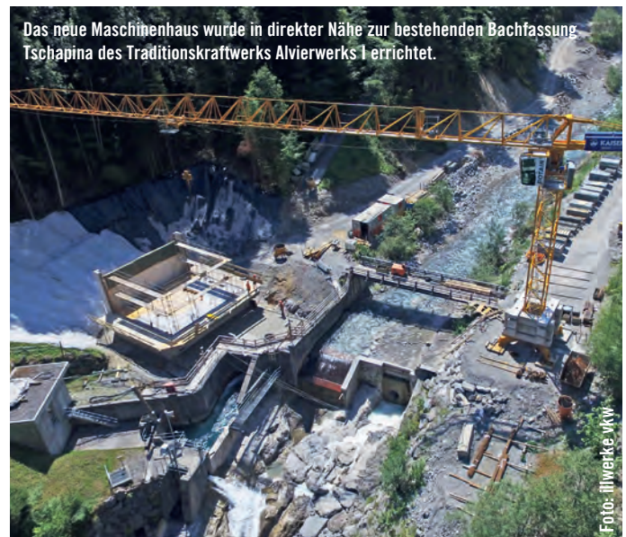
Beim Bau der Wasserfassung im Gemeindegebiet von Brand war man bemüht, den Spielbetrieb am direkt angrenzenden Golfplatz nicht durch die Bauarbeiten zu stören.
