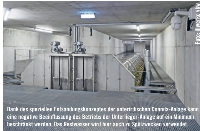
Von zwei Verteilkanälen aus fließt das Wasser über die jeweils 12 in Serie geschalteten Coanda-Rechen vom Typ Grizzly Optimus vom Branchenspezialisten Wild Metal.
