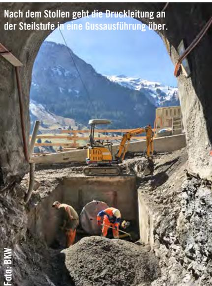
Nach dem Stollen geht die Druckleitung an der Steilstufe in eine Gussausführung über.
