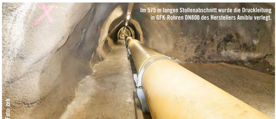
Im 575 m langen Stollenabschnitt wurde die Druckleitung in GFK-Rohren DN800 des Herstellers Amiblu verlegt.
