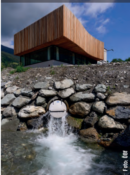
Nach der Turbinierung wird das abgearbeitete Triebwasser wieder in den Luggauerbach eingeleitet.
