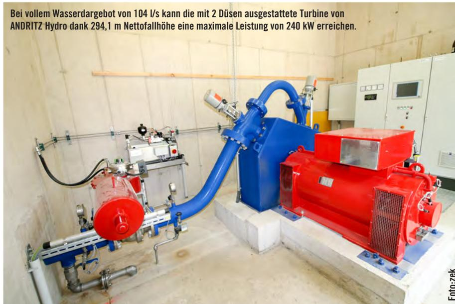
Bei vollem Wasserdargebot von 104 l/s kann die mit 2 Düsen ausgestattete Turbine von ANDRITZ Hydro dank 294,1 m Nettofallhöhe eine maximale Leistung von 240 kW erreichen.
