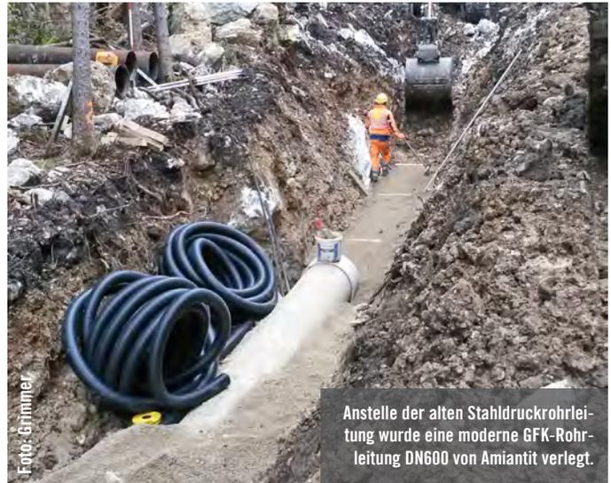
Anstelle der alten Stahlrohrleitung wurde eine moderne GFK-Rohrleitung DN600 von Amiantit verlegt.
