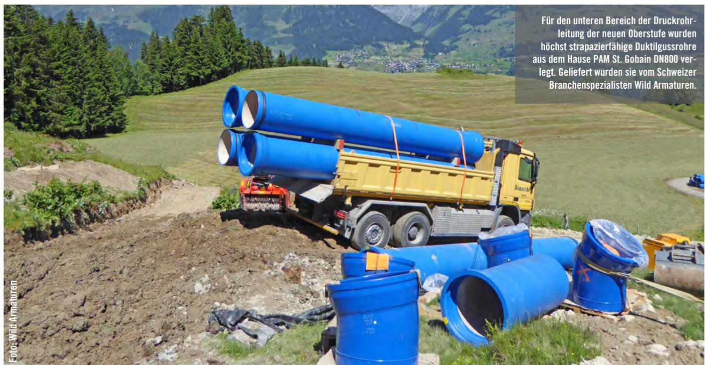
Für den unteren Bereich der Druckrohrleitung der neuen Oberstufe wurden höchst strapazierfähige Duktigussrohre aus dem Hause PAM St. Gobain DN800 verlegt. Geliefert wurden sie vom Schweizer Branchenspezialisten Wild Armaturen.
