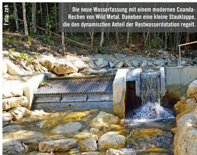
Die neue Wasserfassung mit einem modernen Coanda-Rechen von Wild Metal. Daneben eine kleine Stauklappe, die den dynamischen Anteil der Restwasserdotations regelt.
