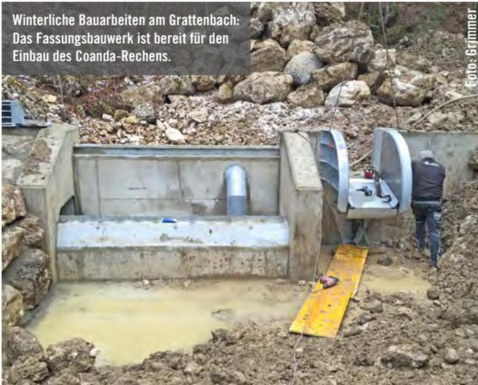
Winterliche Bauarbeiten am Grattenbach: Das Fassungsbauwerk ist bereit für den Einbau des Coanda-Rechens.
