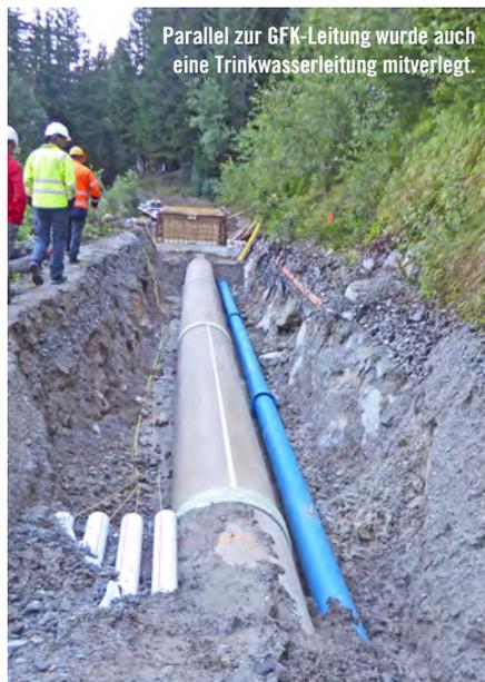
Parallel zur GFK-Leitung wurde auch eine Trinkwasserleitung mitverlegt.
