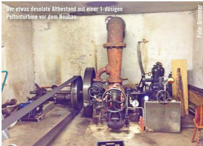
Der etwas desolante Altbestand mit einer 1-düsigen Pelton-turbine vor dem Neubau.
