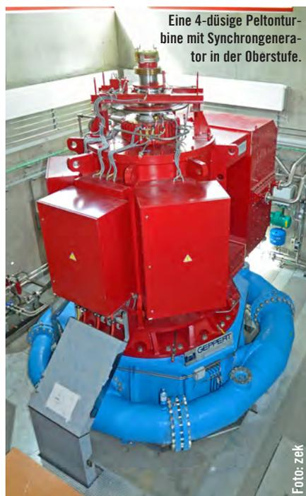
Eine 4-düsige Pelton-turbine mit Synchron-generator in der Oberstufe.
