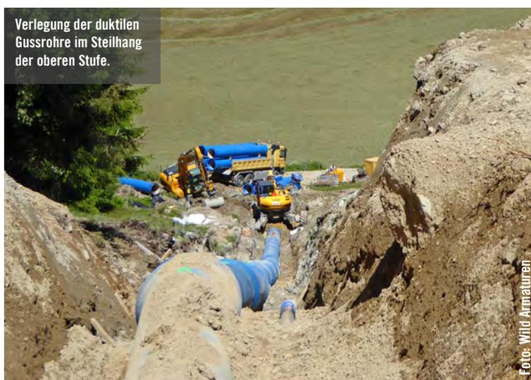
Verlegung der duktilen Gussrohre im Steilhang der oberen Stufe.
