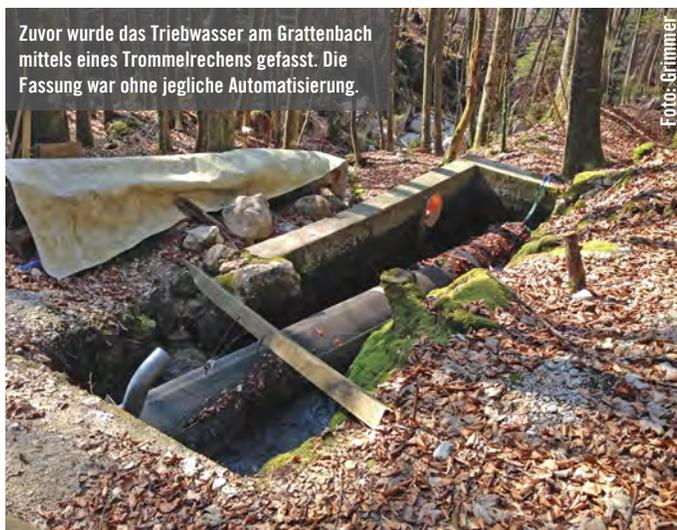
Zuvor wurde das Triebwasser am Grattenbach mittels eines Trommelrechen gefasst. Die Fassung war ohne jegliche Automatisierung.
