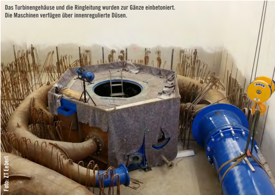
Verteilrohrleitung
