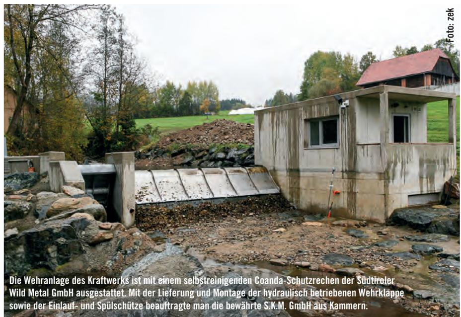
Die Wehranlage des Kraftwerks ist mit einem selbstreinigenden Coanda-Schutzrechen der Südtiroler Wild Metal GmbH ausgestattet. Mit der Lieferung und Montage der hydraulisch betriebenen Wehrklappe sowie der Einlauf- und Spülschütze beauftragte man die bewährte S.K.M. GmbH aus Kammern.
