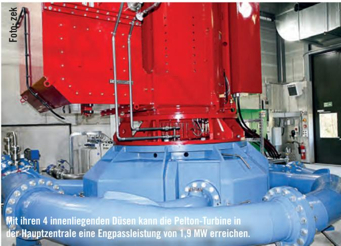
Mit ihren 4 innenliegenden Düsen kann die Pelton-Turbine in der Hauptzentrale eine Engpassleistung von 1,9 MW erreichen.
