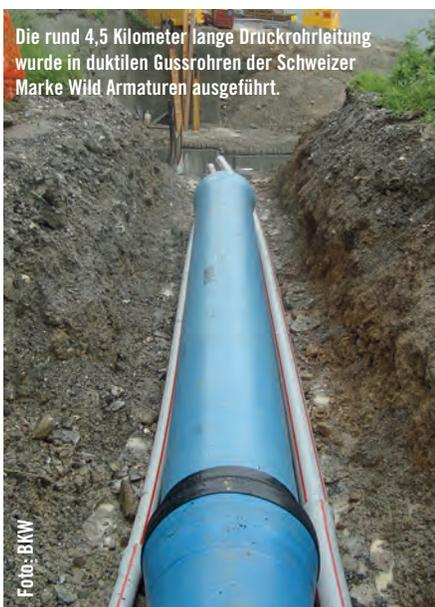
Die rund 4,5 Kilometer lange Druckrohrleitung wurde in duktilen Gussrohren der Schweizer Marke Wild Armaturen ausgeführt.
