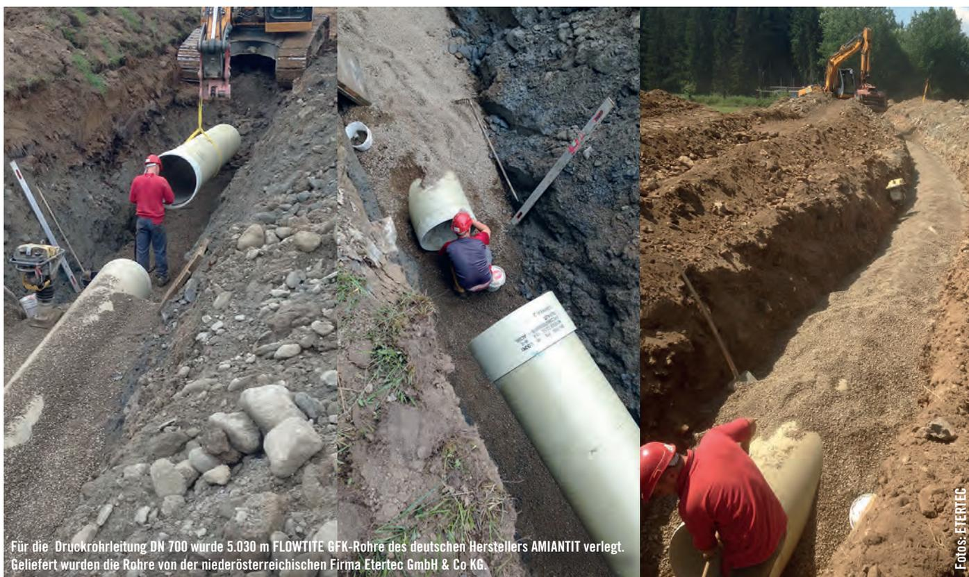
Für die Druckrohrleitung DN 700 wurde 5.030 m FLOWTITE GFK-Rohre des deutschen Herstellers AMIANTIT verlegt. Geliefert wurden die Rohre von der niederösterreichischen Firma Etertec GmbH & Co KG.
