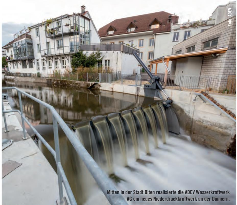
Mitten in der Stadt Olten realisierte die ADEV Wasserkraftwerk AG ein neues Niederdruckkraftwerk an der Dünnern.
