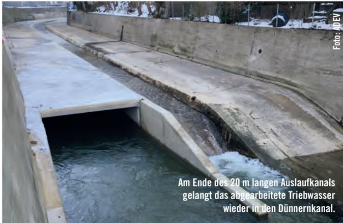
Am Ende des 20 m langen Auslaufkanals gelangt das abgearbeitete Triebwasser wieder in den Dünnerkanal.
