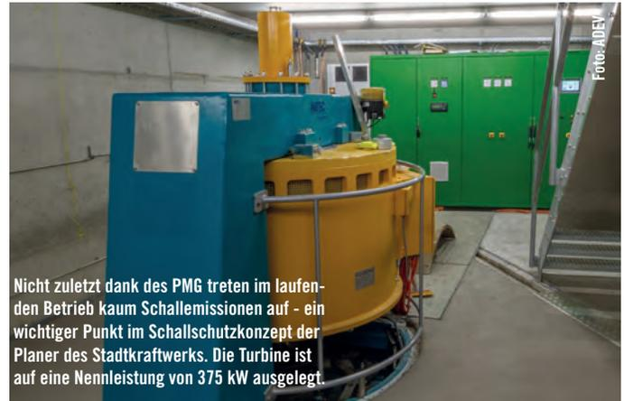
Nicht zuletzt dank des PMG treten im laufenden Betrieb kaum Schallemissionen auf - ein wichtiger Punkt im Schallschutzkonzept der Planer des Stadtkraftwerks. Die Turbine ist auf eine Nennleistung von 375 kW ausgelegt.
