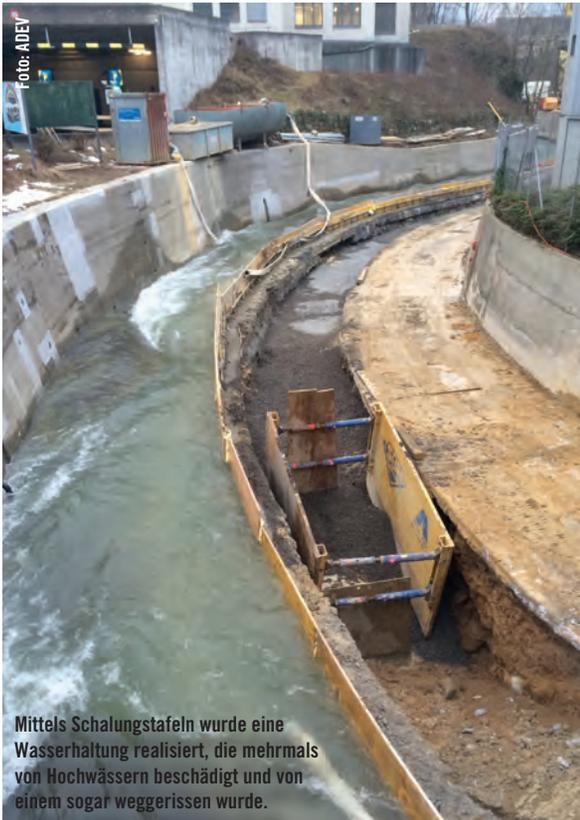
Mittels Schalungstafeln wurde eine Wasserhaltung realisiert, die mehrmals von Hochwässern beschädigt und von einem sogar weggerissen wurde.
