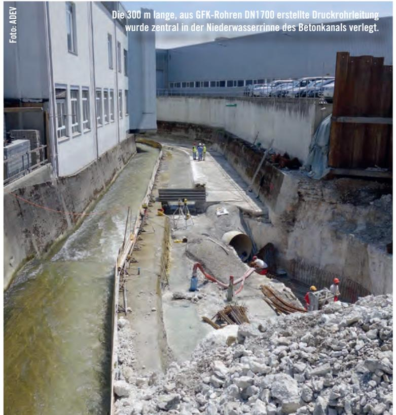
Die 300 m lange, aus GFK-Rohren DN1700 erstellte Druckrohrleitung wurde zentral in der Niederwasserrinne des Betonkanals verlegt.
