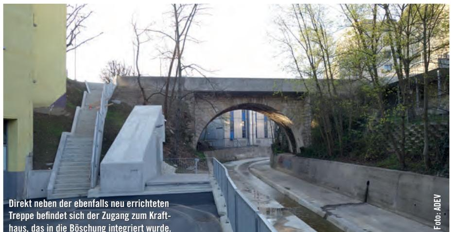
Direkt neben der ebenfalls neu errichteten Treppe befindet sich der Zugang zum Krafthaus, das in die Böschung integriert wurde.
