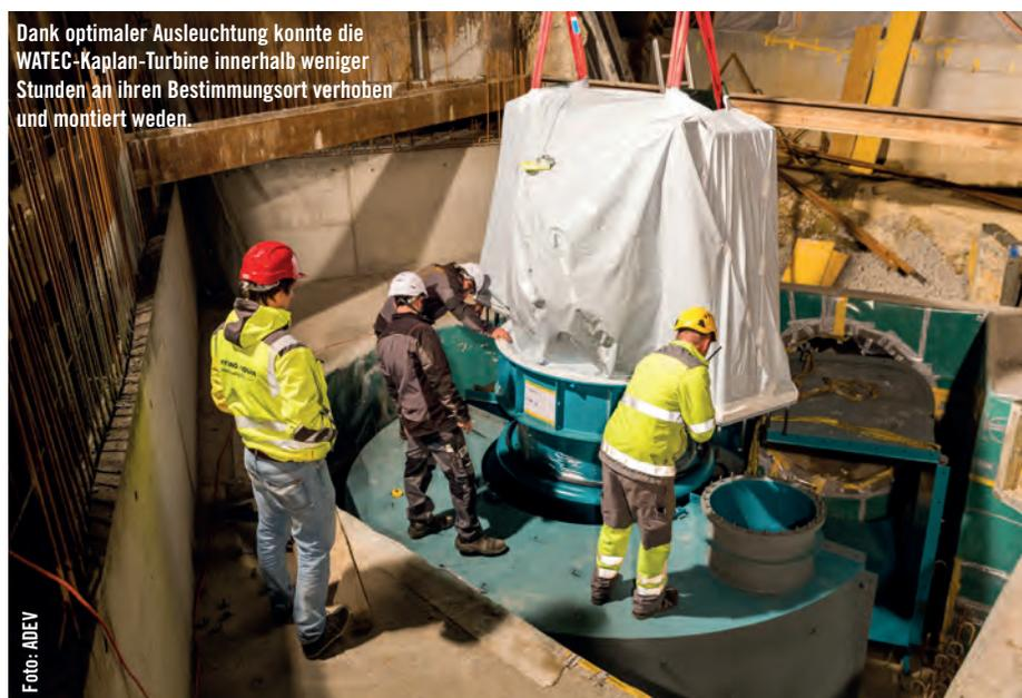
Dank optimaler Ausleuchtung konnte die WATEC-Kaplan-Turbine innerhalb weniger Stunden an ihren Bestimmungsort verhooben und montiert werden.
