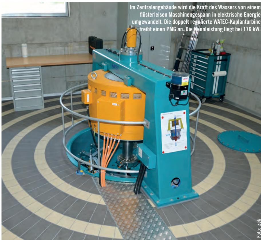
Im Zentralgebäude wird die Kraft des Wassers von einem flüsterleisen Maschinengespann in elektrische Energie umgewandelt. Die doppelt regulierte WATEC-Kaplanturbine treibt einen PMG an. Die Nennleistung liegt bei 176 kW.
