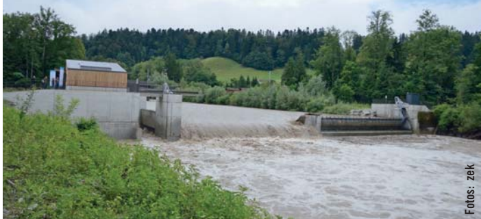
Die Stauklappen messen 23 x 2,7 m. Im Hochwasserfall werden sie in Minutenschnelle umgelegt und der Kraftwerksbetrieb eingestellt, damit der freie Geschiebetrieb möglich wird.
