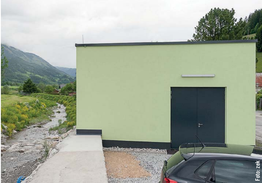
Das Anfang 2016 in Betrieb genommene Kraftwerk Bärndorferbach ist bereits das dritte Wasserkraftwerk der Städtischen Betriebe Rottenmann.
