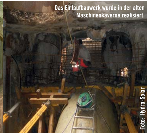
Die Rohrleitung wurde auf speziellen Stahljochen aufgeständert. Ihre Gesamtlänge beträgt rund 165 m.
