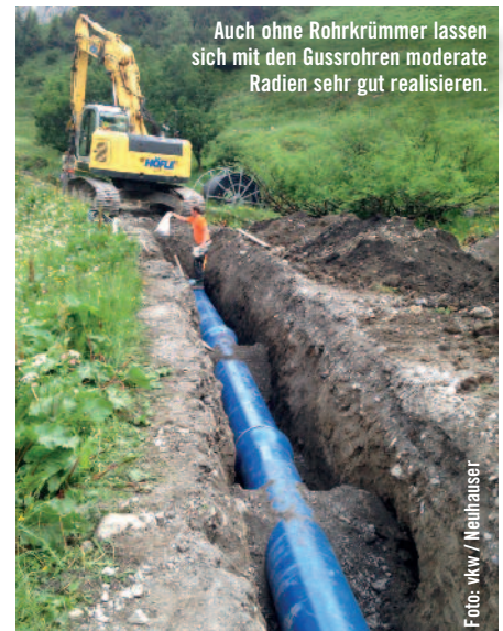
Aufgrund der einfachen VRS-T®-Verbindungen wurde eine hohe Verlegeleistung erzielt.
