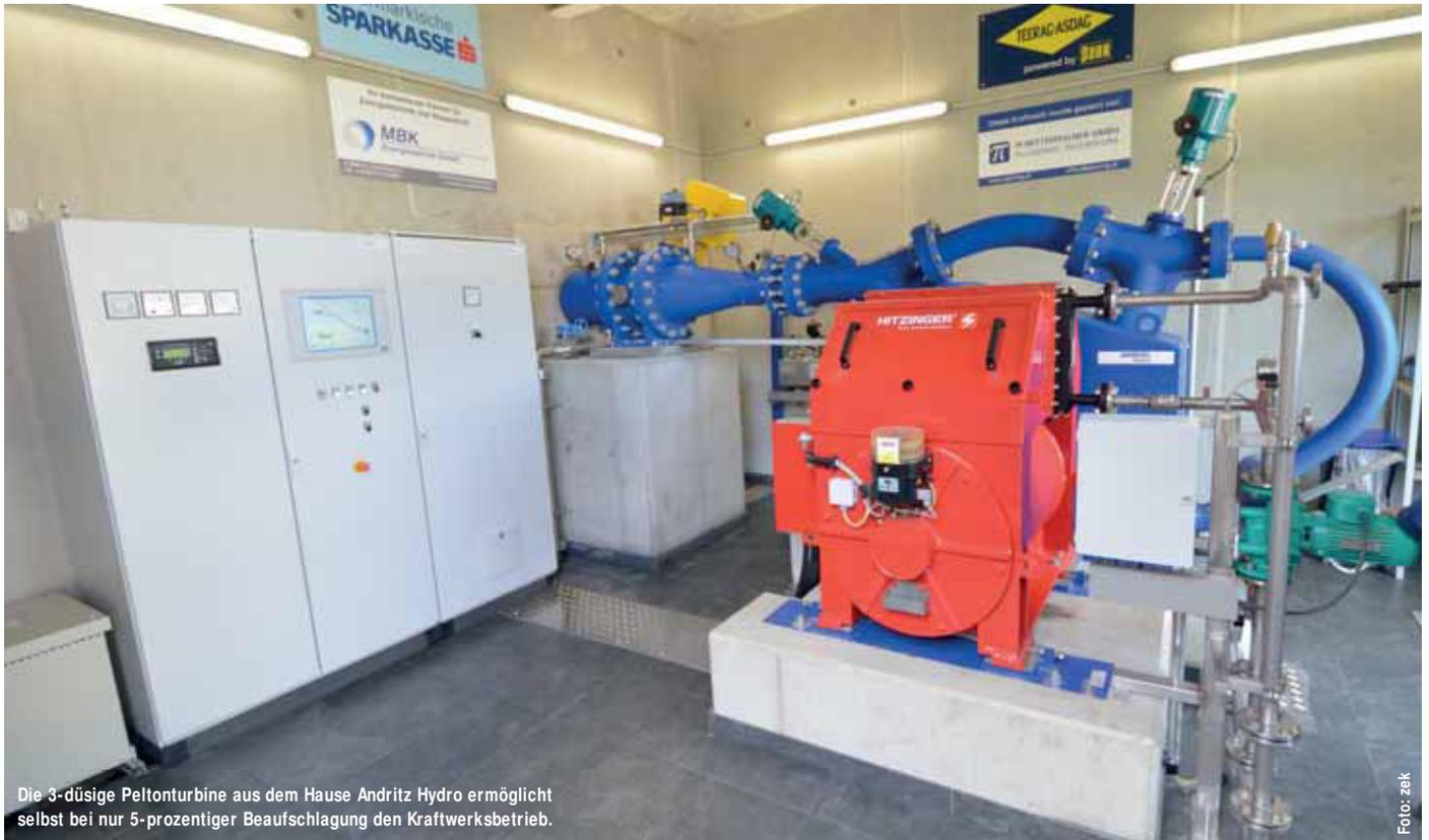
Die 3-düsige Pelton-turbine aus dem Hause Andritz Hydro ermöglicht selbst bei nur 5-prozentiger Beaufschlagung den Kraftwerksbetrieb.
