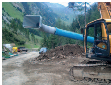
Das Anschlussstück an den Sandfang wird mit dem ersten Druckrohr an den Bestimmungsort verhooben.
