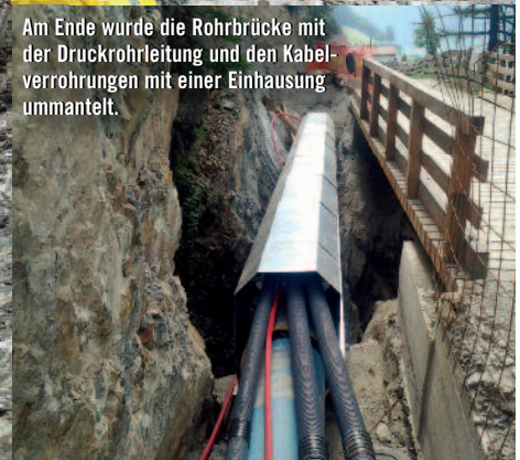
Um ein Einfrieren zu verhindern, wurden die Rohre von TRM mit einer Isolierung versehen.
