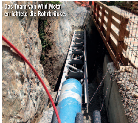
Um ein Einfrieren zu verhindern, wurden die Rohre von TRM mit einer Isolierung versehen.
