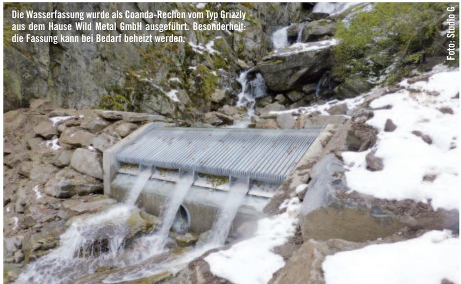
Die Wasserfassung wurde als Coanda-Rechen vom Typ Grizzly aus dem Hause Wild Metal GmbH ausgeführt. Besonderheit: die Fassung kann bei Bedarf beheizt werden.
