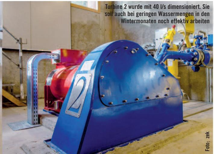
Turbine 2 wurde mit 40 l/s dimensioniert. Sie soll auch bei geringen Wassermengen in den Wintermonaten noch effektiv arbeiten
