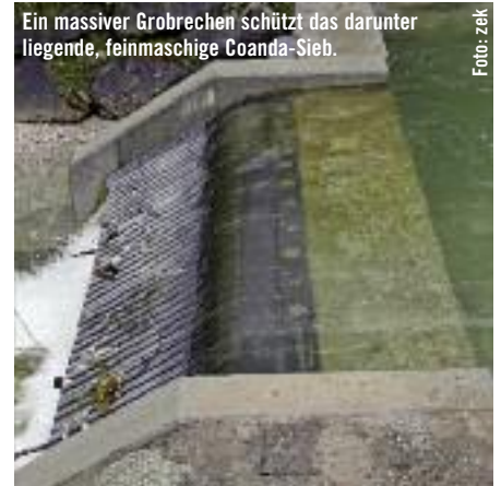
Die Wasserfassung wurde knapp unterhalb des Zusammenflusses von Furkelbach und Mühlbach positioniert und mit einem Coanda-Rechen im patentierten Grizzly-Modulsystem ausgestattet.
