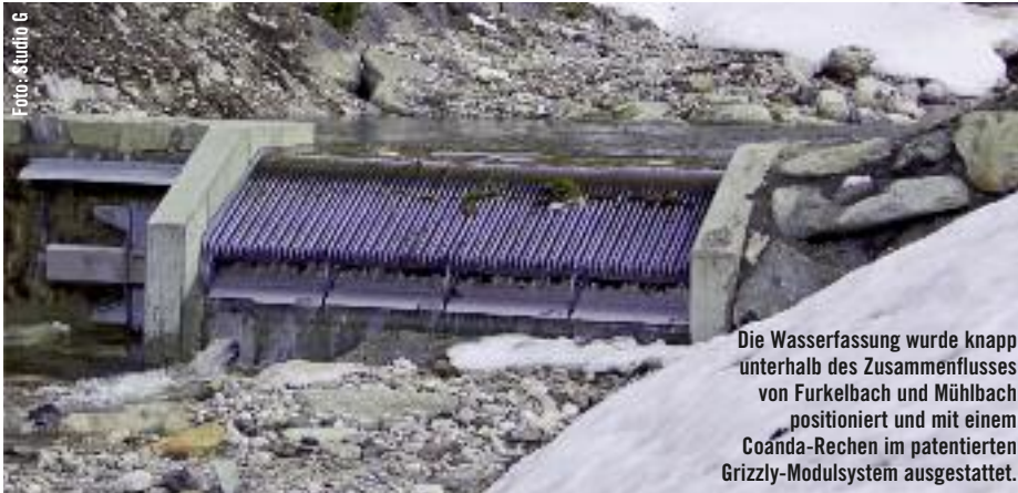
Ein massiver Grobrechen schützt das darunter liegende, feinmaschige Coanda-Sieb.
