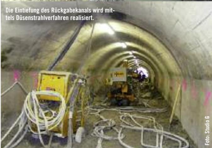
Die Eintiefung des Rückgabekanal wird mittels Düsenstrahlverfahren realisiert.
