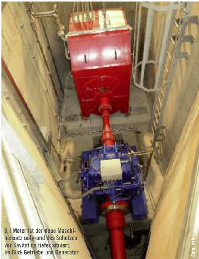
3,1 Meter ist der neue Maschinensatz aufgrund des Schutzes vor Kavitation tiefer situiert. Im Bild: Getriebe und Generator.
