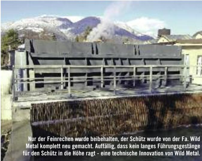
Nur der Feinrechen wurde beibehalten, der Schütz wurde von der Fa. Wild Metal komplett neu gemacht. Auffällig, dass kein langes Führungsgestänge für den Schütz in die Höhe ragt - eine technische Innovation von Wild Metal.
