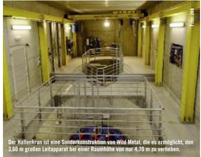
Der Hallenkran ist eine Sonderkonstruktion von Wild Metal, die es ermöglicht, den 3,60 m großen Leitapparat bei einer Raumhöhe von nur 4,70 m zu verheben. Foto: zek
