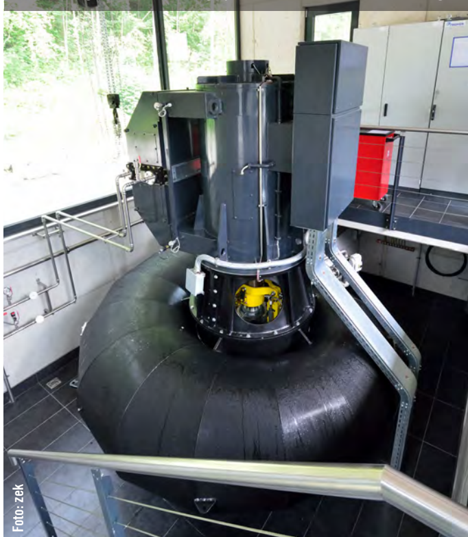
Ungewöhnlich in der Optik, stark in der Leistung: Die doppelt-regulierte Kaplan-Spiralturbine aus dem Hause Troyer AG treibt einen wassergekühlten Generator von der Fa. Hitzinger an. Das Maschinengespann erreicht dabei 145 kW Nennleistung.
