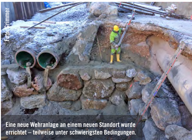
Die Verlegung der 181 m langen Druckrohrleitung aus FLOWTITE Röhren DN1200 wurde vom Team der WLW in muster-gültiger Weise erledigt.
