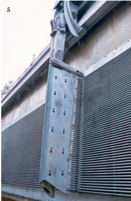
5. Besonders fischfreundlicher horizontaler Rechen mit einem Stababstand von nur 15 mm
