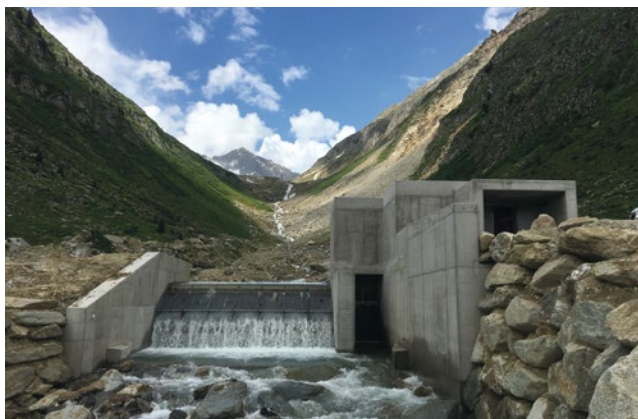
Wasserfassung im alpinen Gelände / Presa d'acqua in territorio alpino
