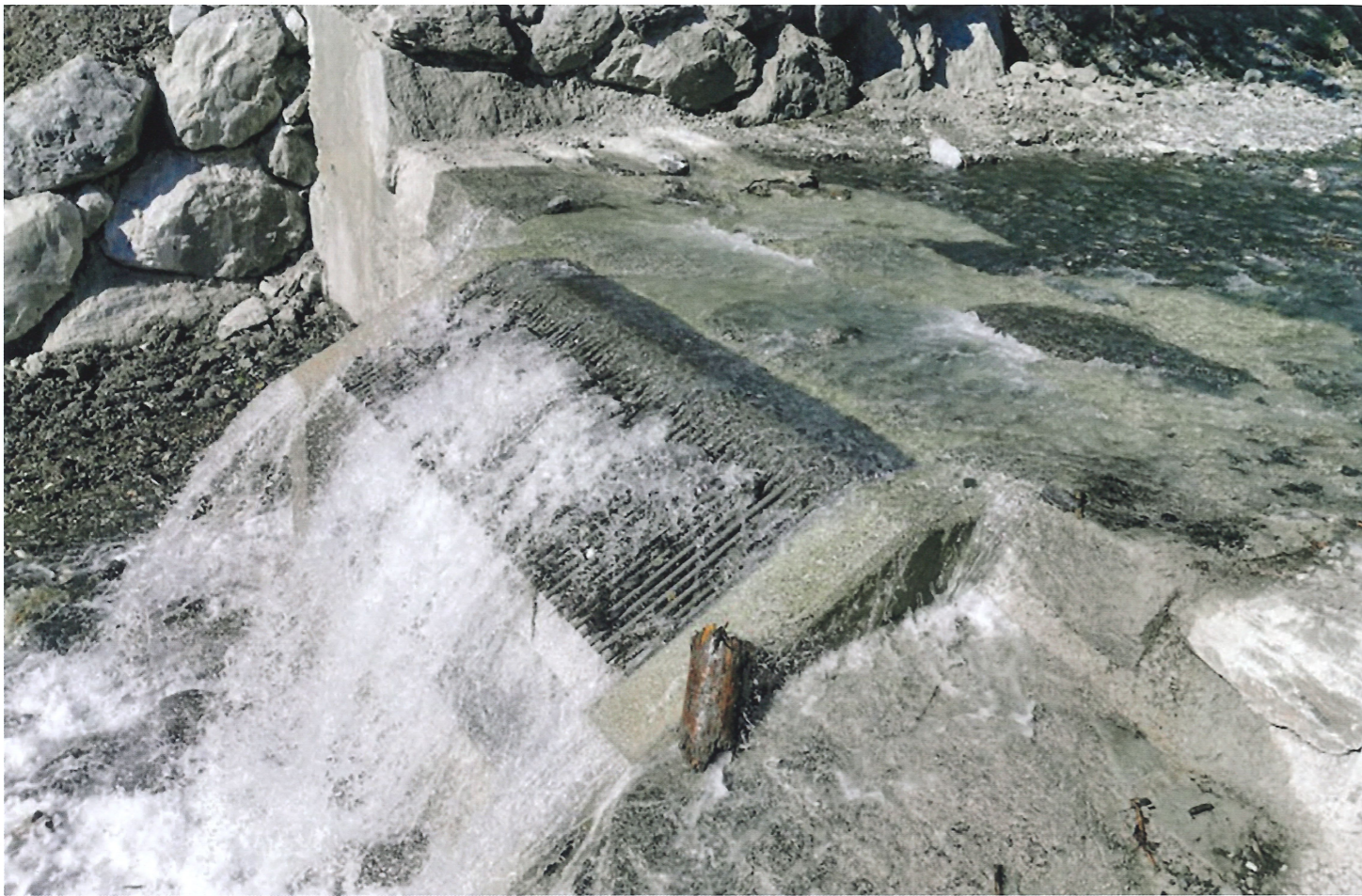
PROTEC 1000 Rechen im Einsatz
