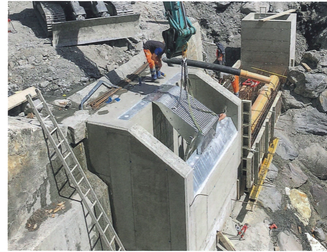
Sorgfältige Montage des PROTEC 1000 Rechens
